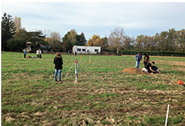
Les travaux d'aménagements du site ont commencé
