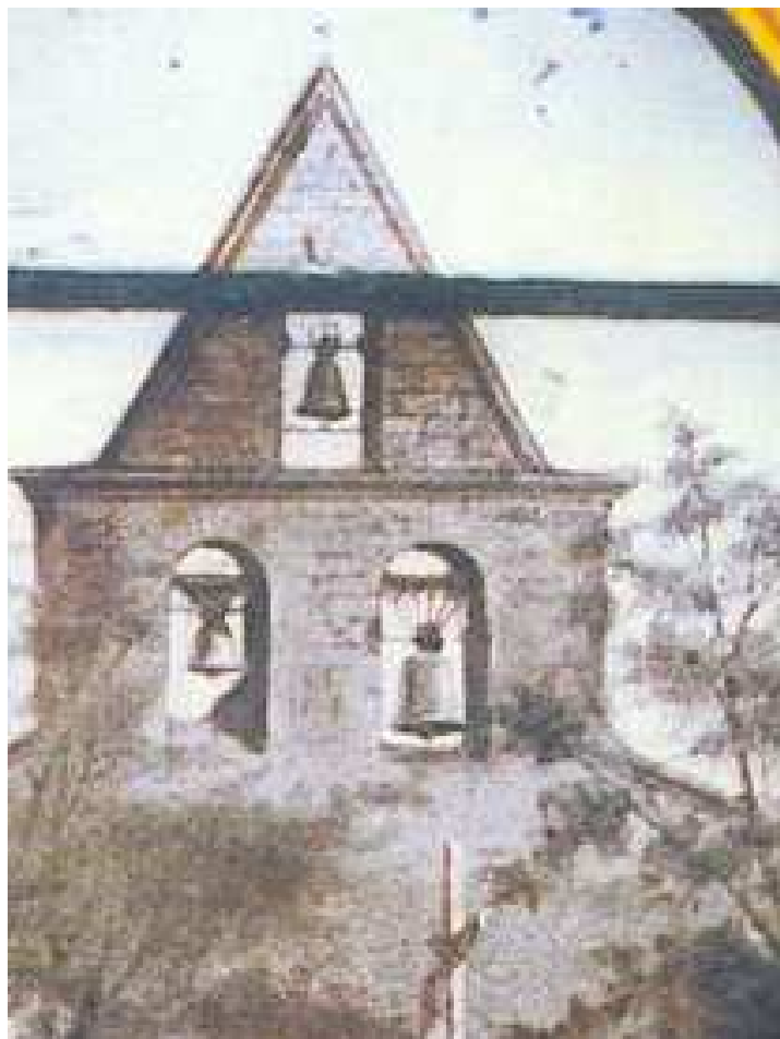
A droite la grosse cloche et le toit de l'église.
