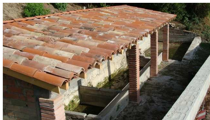
Été 2009, le lavoir en cours de rénovation.
