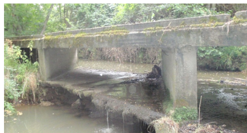
Obstacle à la continuité : plan d'eau et envasement à l'amont, creusement à l'aval
